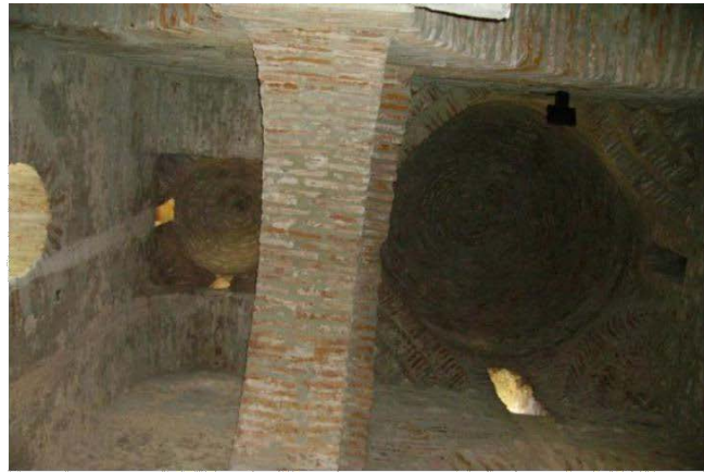
Fig. 5 Il sistema delle cupole dall'interno
